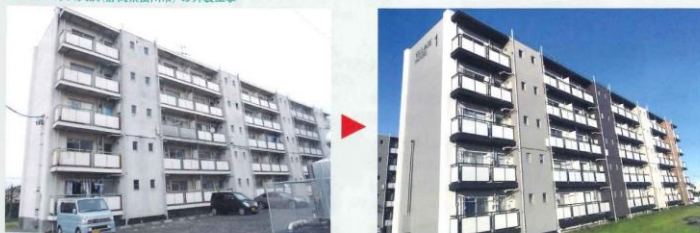
1971年築、全2棟・80戸、RC造5階建。外装工事でイメージ一新
