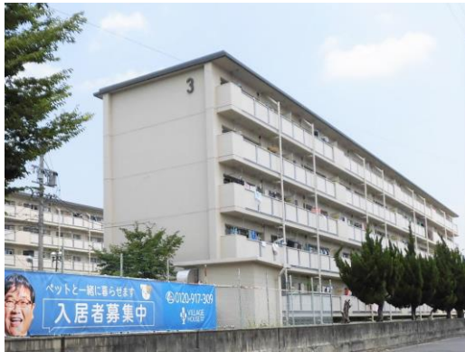
ビレッジハウス上野服部第二 (ウエノハットリダイニ) 三重県 伊賀市
