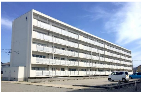
ビレッジハウス押水（オシミズ）80戸 石川県 羽咋郡宝達志水町
