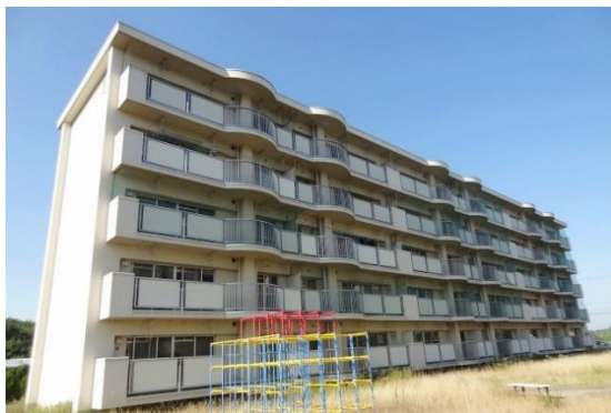
ブリッジハウス野間田（ノマダ）60戸 香川県 さぬき市
