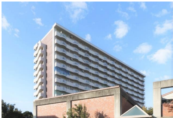
ビレッジハウス浜松タワー（ハママツタワー）153戸 静岡県 浜松市
