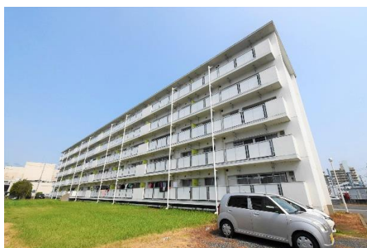
ビレッジハウス足利朝倉（アシカガアサクラ）80戸 栃木県 足利市
